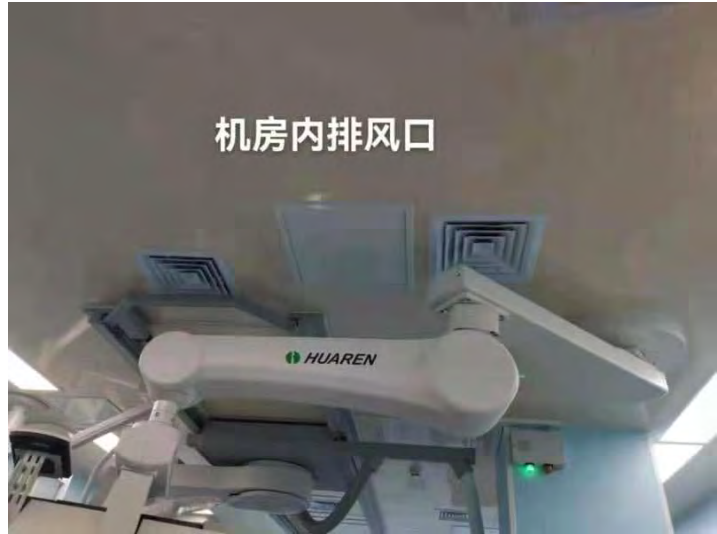
机房内排风口
