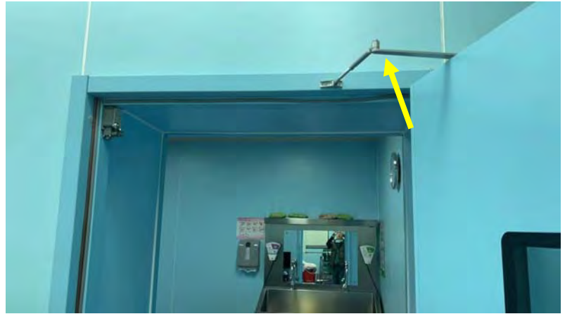
控制室门安装闭门器
