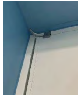
手动平开门的门灯联锁装置
