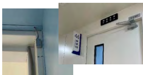
手动平开门的门灯联锁装置、闭门器
