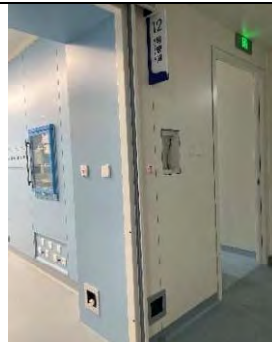
自动延时和红外防夹电动门、非接触式闭门器
