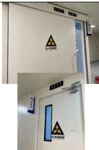
防护门外电离辐射标志和警示灯 (左: 患者通道, 右: 污物通道)
