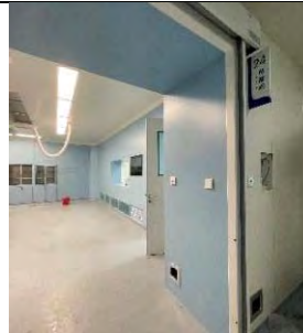
自动延时和红外防夹电动门、非接触式闭门器
