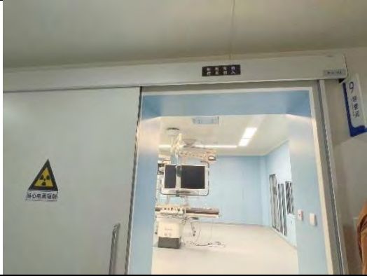
防护门外电离辐射标志和警示灯
