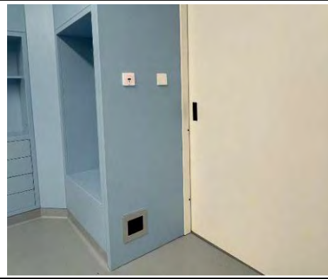
自动延时和红外防夹电动门、非接触式闭门器
