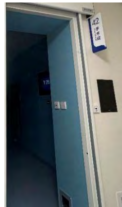
自动延时和红外防夹电动门、非接触式闭门器
