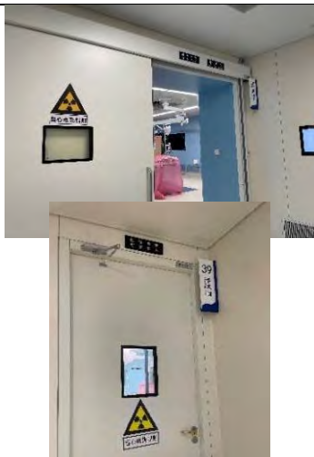
防护门外电离辐射标志和警示灯 (左: 患者通道, 右: 污物通道)
