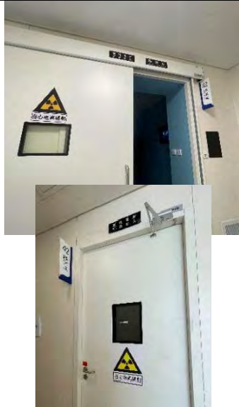
防护门外电离辐射标志和警示灯 (左: 患者通道, 右: 污物通道)
