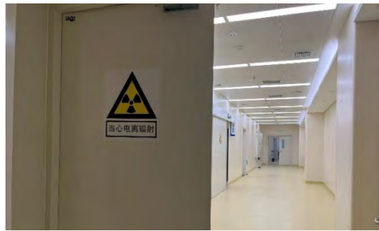
核医学科出口防护门外放射性标志
