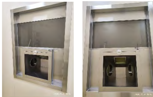
二个注射窗，左侧 10mmPb 注射 Tc-99m，右侧 40mmPb 注射 F-18
