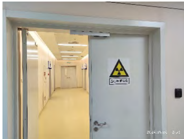
核医学科控制区入口门外放射性标志和门禁
