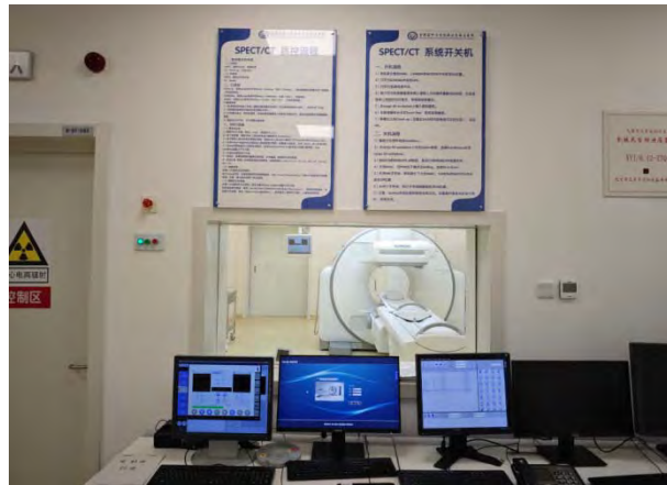
PET/CT 控制室隔室操作观察窗
