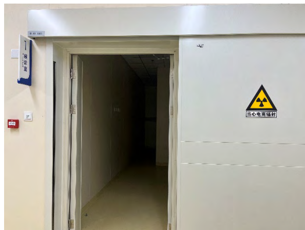
候诊室门外放射性标志
